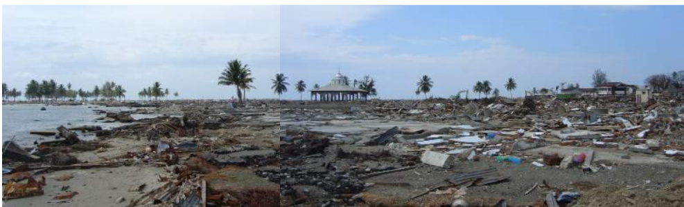
Bangunan yang hancur pada Gempa Aceh tahun 2004
