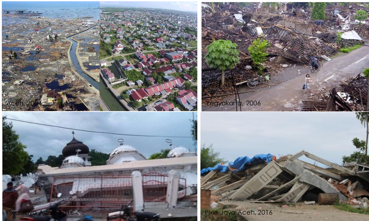
Gambar 5 Bangunan yang hancur pada beberapa kejadian gempa di Indonesia
